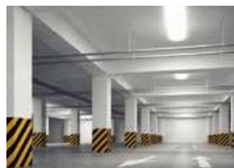
Interior de edificaciones
